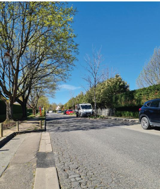
(entre le rond-point de la clémenterie et l'école Pré-Seigneur). Il s'agit d'une reprise ponctuelle des bordures de trottoir, de la réfection de l'ensemble de la chaussée et des trottoirs, de la création et la mise aux normes des passages piétons et des arrêts de bus et de la création de deux plateaux ralentisseurs.
