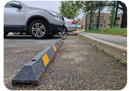
Mise en place de bandes « Stop roues » sur les places de stationnement en bataille, afin d'éviter que les capots ou coffres des véhicules ne gênent la circulation des piétons sur le trottoir. Extension de la zone bleue au petit parking situé à côté du parc de Marolles pour favoriser la rotation des véhicules.
