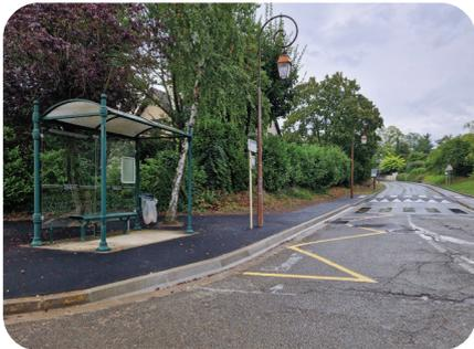
Mise aux normes de l'arrêt de bus de la Croisée des chemins avec une extension de la plateforme pour sécuriser l'attente des enfants pour les bus scolaires. Un peu plus haut, au niveau du 491, chemin des Groux, un coussin lyonnais a été installé en remplacement d'un coussin berlinois dont les fixations étaient usagées.
