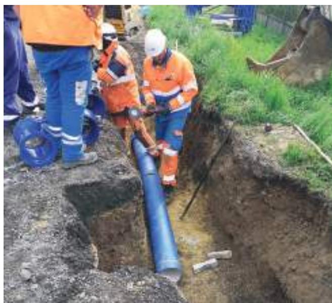
Saint-Père (3 km). Ce chantier a été réalisé en micro tranchée afin de limiter la durée, le coût et l'impact sur la circulation.
